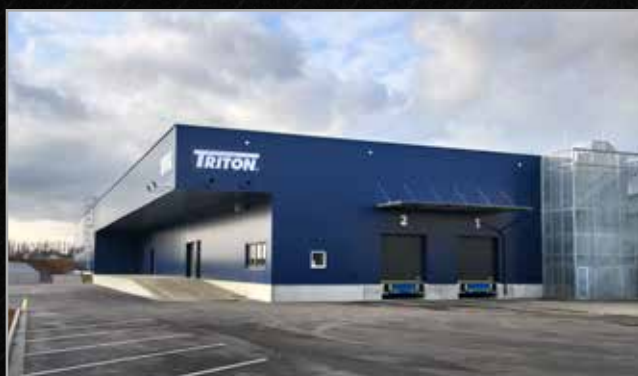
7. 12. 2021 byla zkolaudovaná nová výrobní hala s užitnou plochou téměř 3 000 m 2 .
