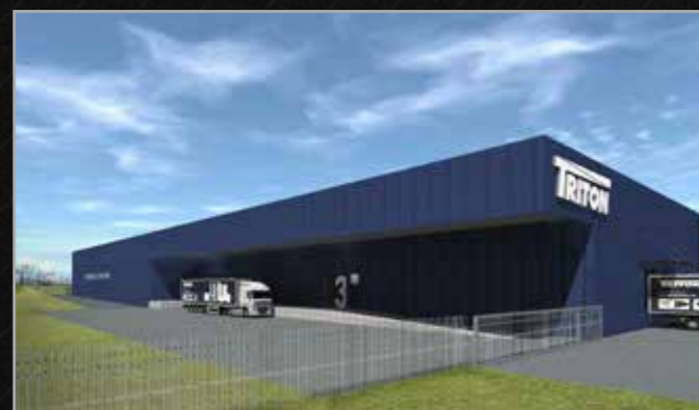
Am 18. Januar wurde mit dem Bau der fünften Fertigungshalle begonnen, die zur Erweiterung der Produktion dient. Die neue Halle wird im Herbst 2021 vollendet.
